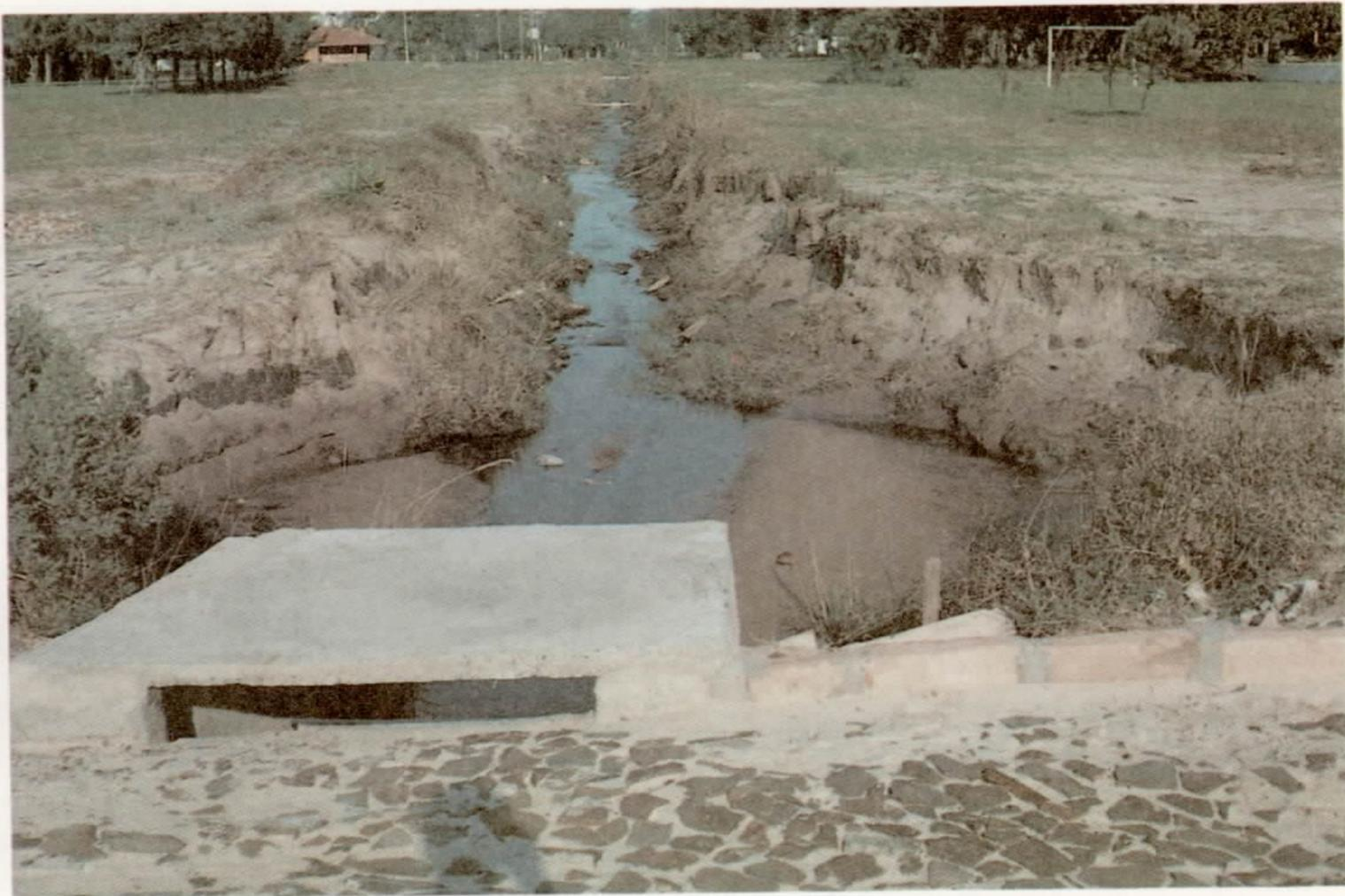
**Foto 7** - Erosão em forma de anfiteatro no talude de canal de drenagem, causada pela retirada de vegetação durante obras de desobstrução. Município de Xangri-Lá.
