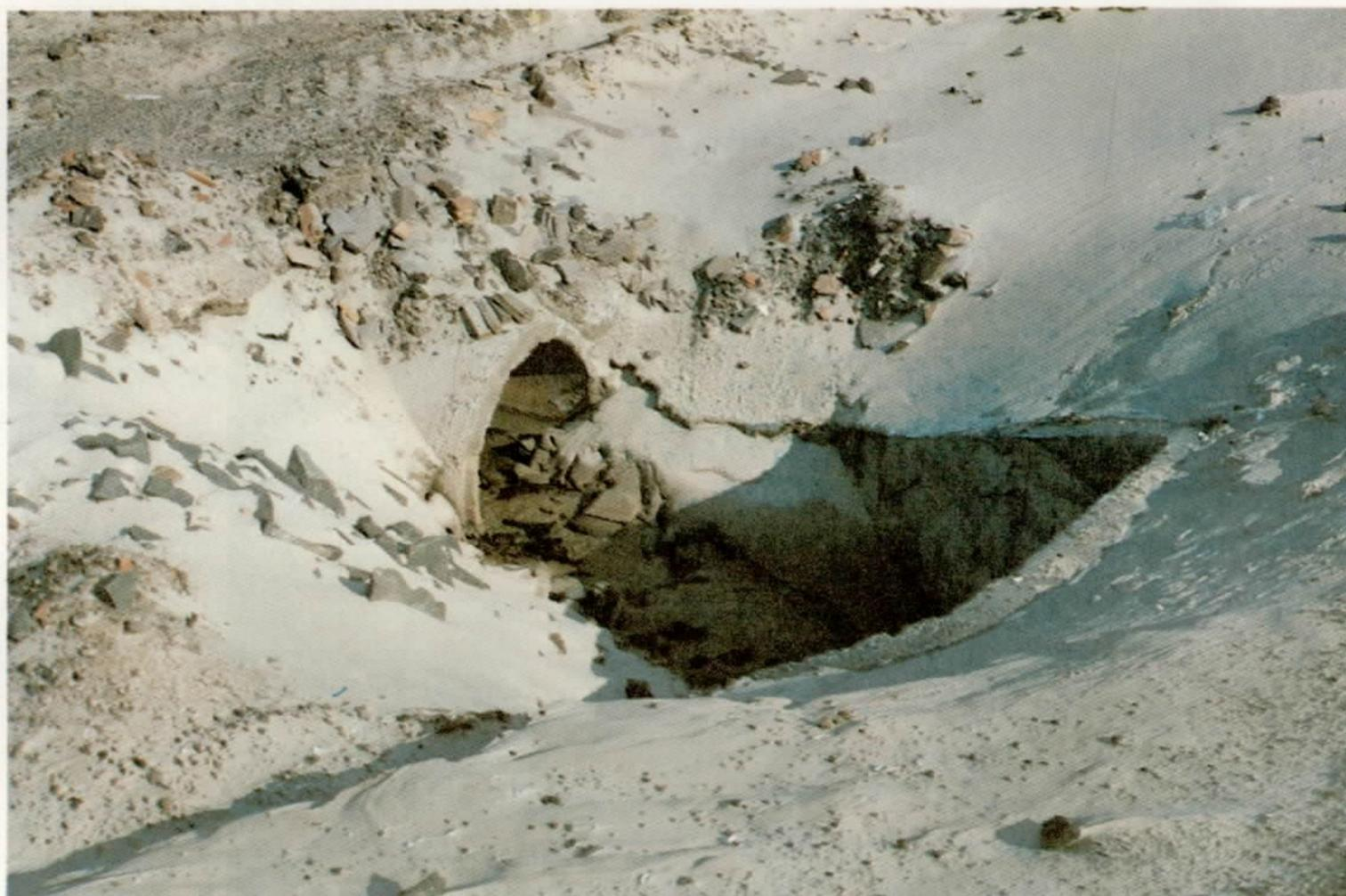
Foto 6 - Assoreamento de conduto pluvial por areia e pedras, à margem da interpraia, entre Xangri-Lá e Rainha do Mar. Município de Xangri-Lá.
